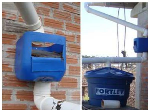
Fig. 4: Filtro em funcionamento
