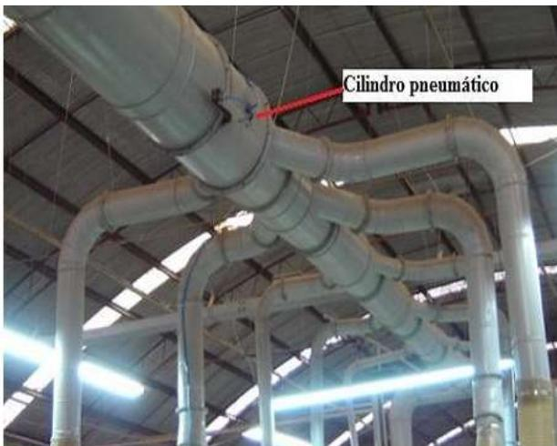
Figura 12: Dampers automáticos com atuador pneumático (Maq. 0710).
