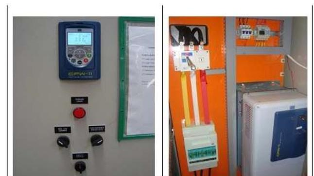
Figura 14: Painel elétrico externo (coluna esquerda) e interno da implementação (coluna direita).
