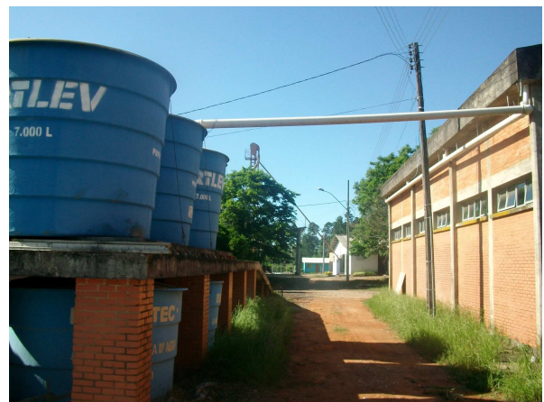
Fig. 1: Esquema de Captação da água da chuva
