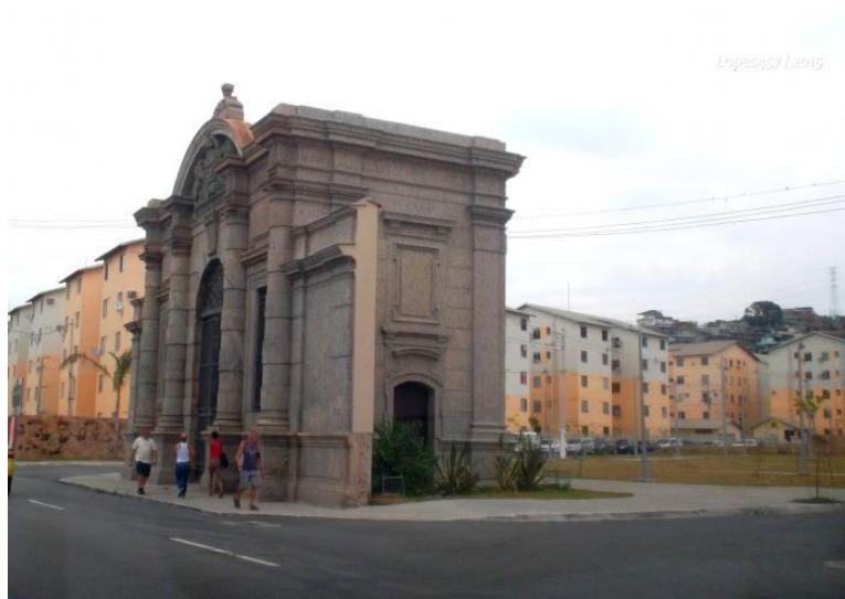
Figura 6 – Pórtico do Presídio Frei Caneca e conjunto habitacional
