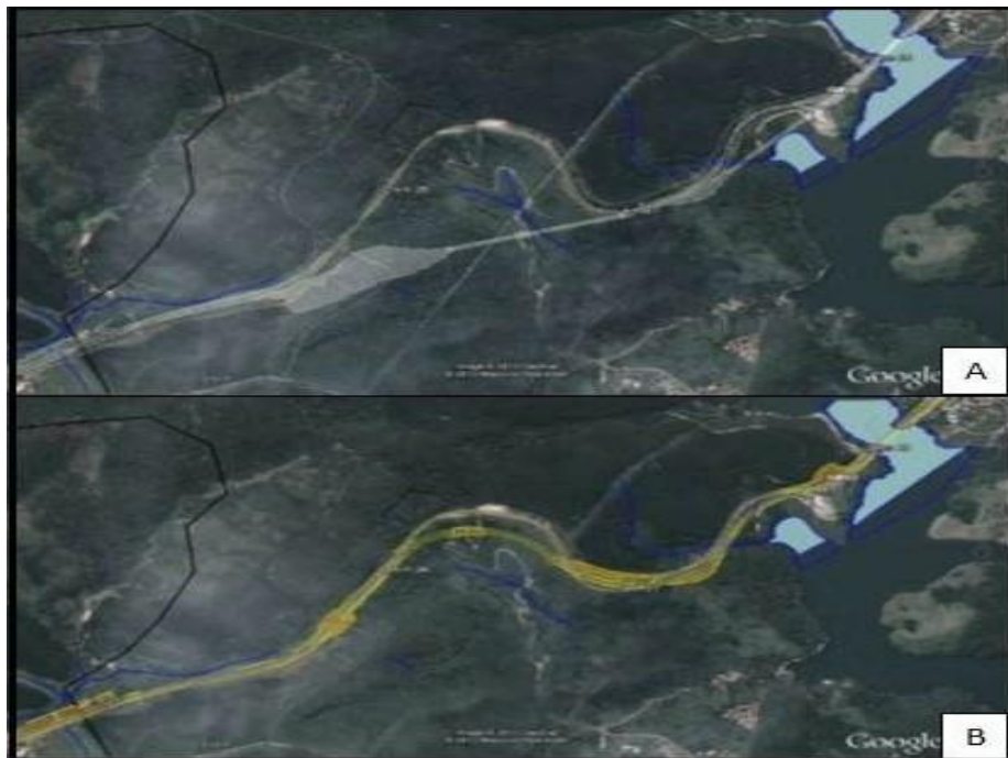
Figura 5 - Trecho da duplicação da Rodovia dos Tamoios - Serrinha.
