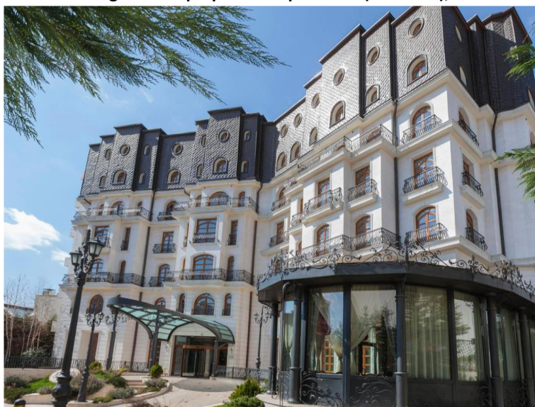
Figura 5 - Epoque Boutique Hotel (Romênia),
