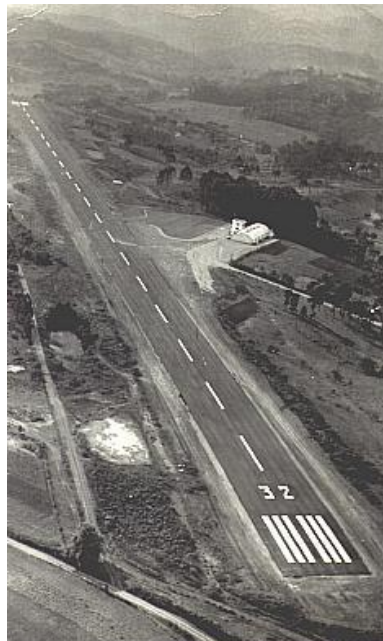
Imagem 19: Pista do Aeroclube de Garibaldi em 1975
