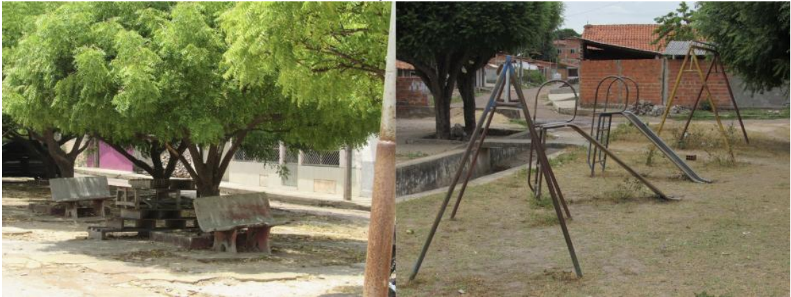
Figuras 4 e 5. Estado de conservação da Praça Nossa Senhora de Fátima, São Bernardo/MA (zona periférica)
