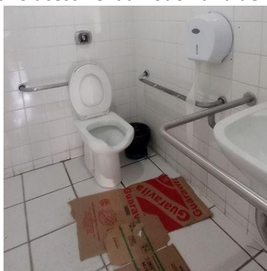
Figura 6. Banheiro acessível da Rodoviária de Vassouras, 2024
