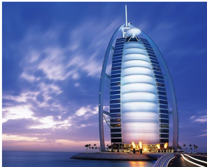
Figura 5. - Hotel Burj Al-Arab, Dubai, Emirados Árabes Unidos
