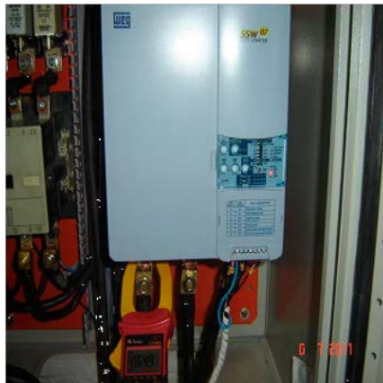
Figura 03: Medição da corrente de trabalho de um motor de indução
