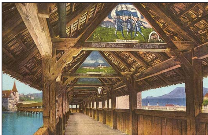
Figura 9: Um exemplo de utilização da memória fotográfica postal é o processo de recuperação da Kapellbrücke – Ponte da Capela, em Lucerna, na Suíça. A ponte de madeira, construída no século XIV, abrigava 147 pinturas de Henry Wagmann, realizadas no séc. XVII. Retratavam lendas, combates e histórias referentes à cidade. Em 1993, um incêndio destruiu parcialmente a ponte e seu acervo iconográfico. Cem pinturas foram perdidas ou profundamente deterioradas, e a estrutura original em madeira também foi parcialmente destruída. O processo de recuperação em curso utiliza como recurso fotografias, filmes, cartões-postais além dos rascunhos originais de Wagmann. Postal de 1929
