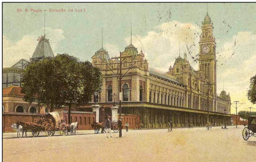
Figura 5: Estação da Luz, São Paulo, 1901 – projeto de modernização da imagem do País passava por se transmitir a idéia de modernidade através da implantação de infra-estrutura urbana compatível com países desenvolvidos do mundo
