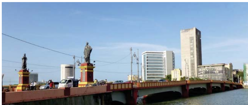
Figura 11 – Ponte Maurício de Nassau
