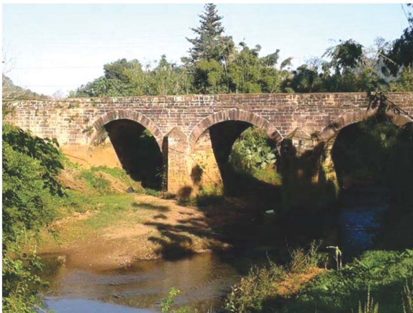
Figura 3 – Ponte do Imperador sobre o arroio Feitoria – Ivoti
