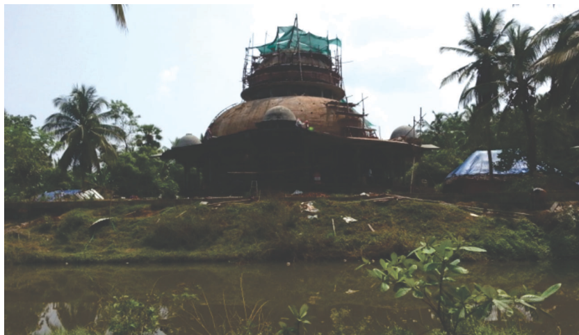
Figura 7 – Shakti Peetha em construção
