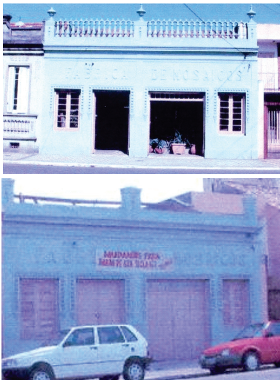
• Imóvel inventariado com alteração da fachada.
