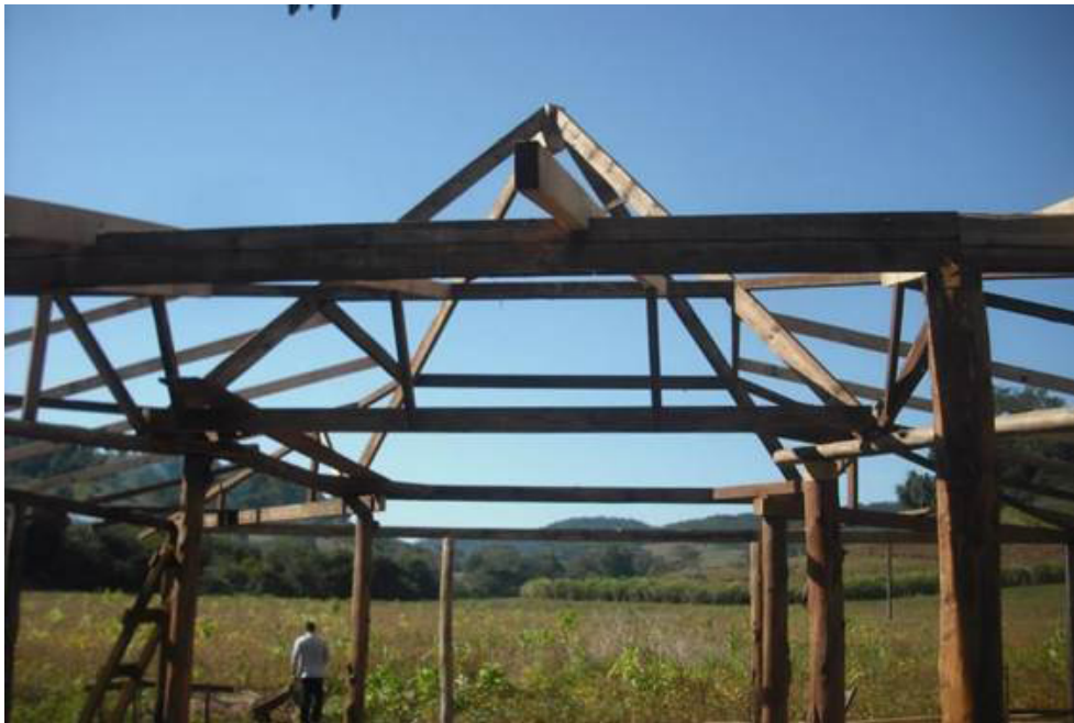
Figura 1 – Início da construção do salão cerimonial em formato de chapéu, 2014.
