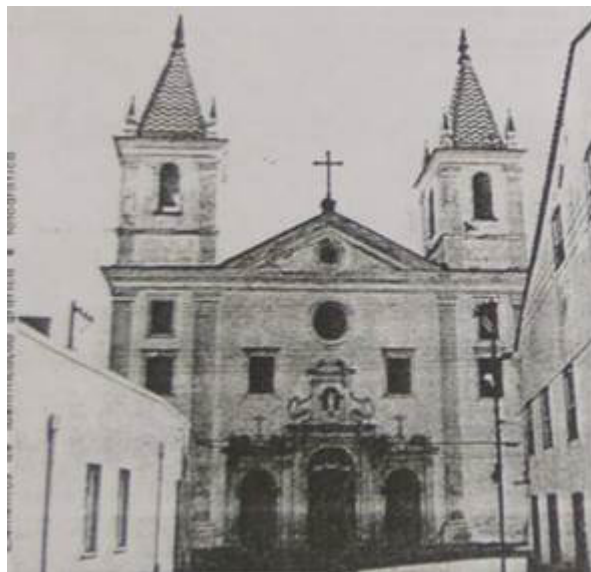
Figura 2 – Fachada da Igreja Matriz Nossa Senhora do Rosário.
