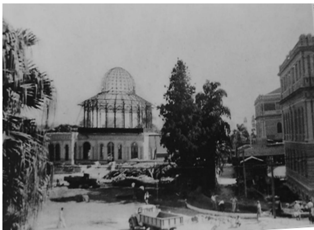
Figura 2 – O prédio do Jardim da Infância em demolição (1939)
